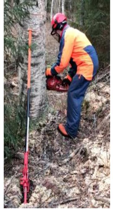
**2.** Lyö tangon hammastuksella merkki puun kylkeen ja sahaa matala (puoli-V) lovi hammastuksen pidon varmistamiseksi. Pidä tunkin ja työntötangon yhdistelmä mahdollisimman lyhyenä kaadon aikana. **ÄLÄ KAADA TUULISELLA SÄÄLLÄ!**
